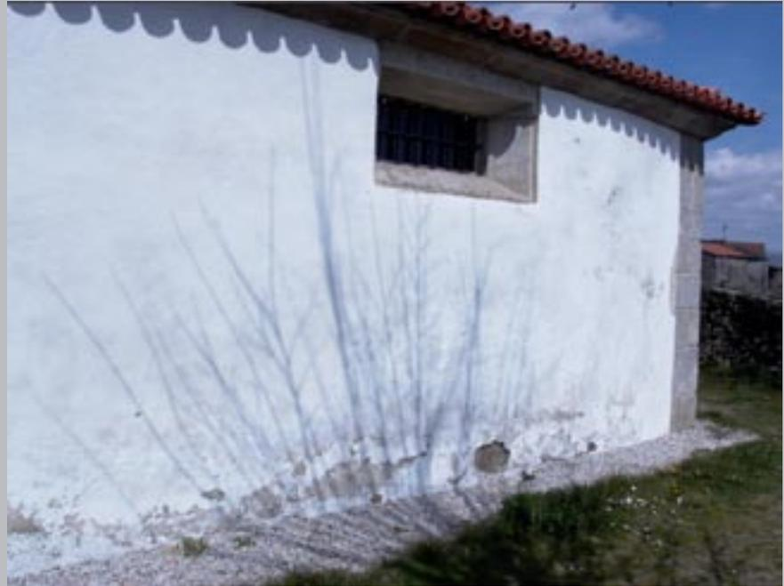
Destacamento do reboco devido a infiltrações
