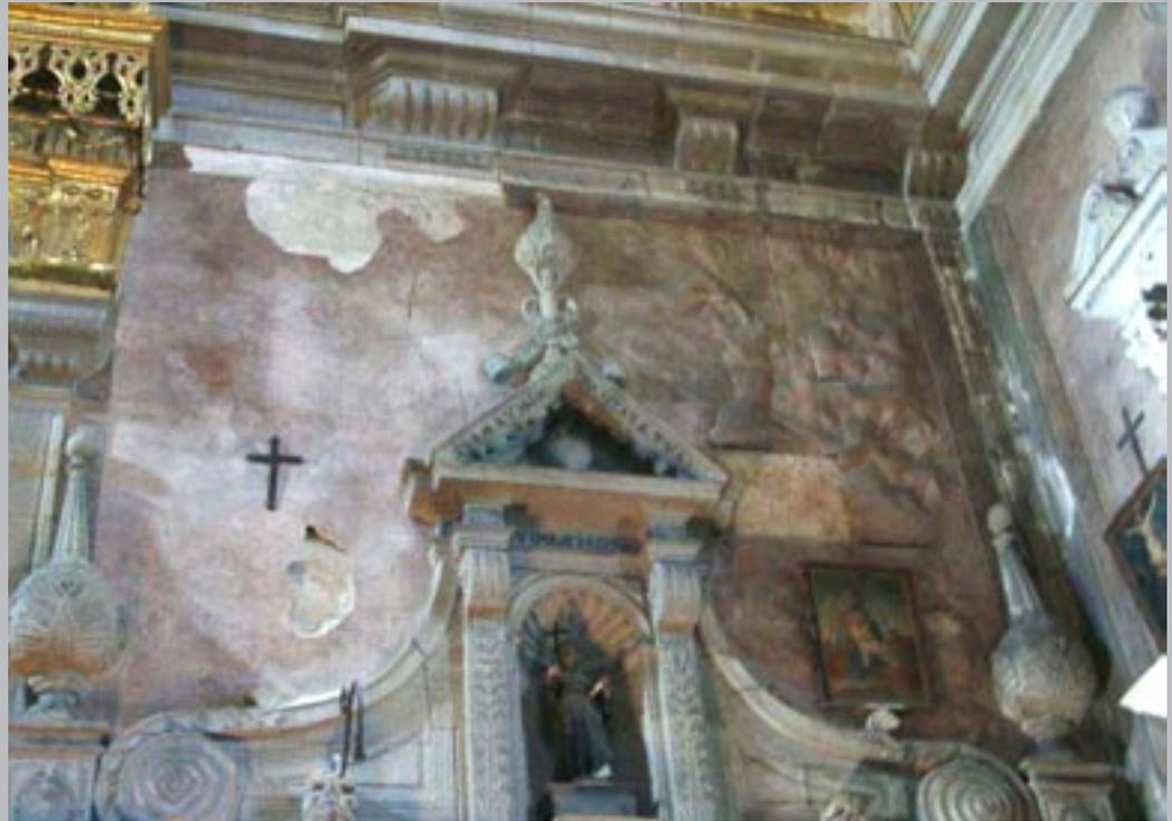
Destacamento do marmoreado devido a infiltrações
